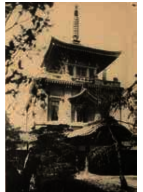
かつての梅窓院本堂だった無礙光会館は、矢部又吉氏の設計。
