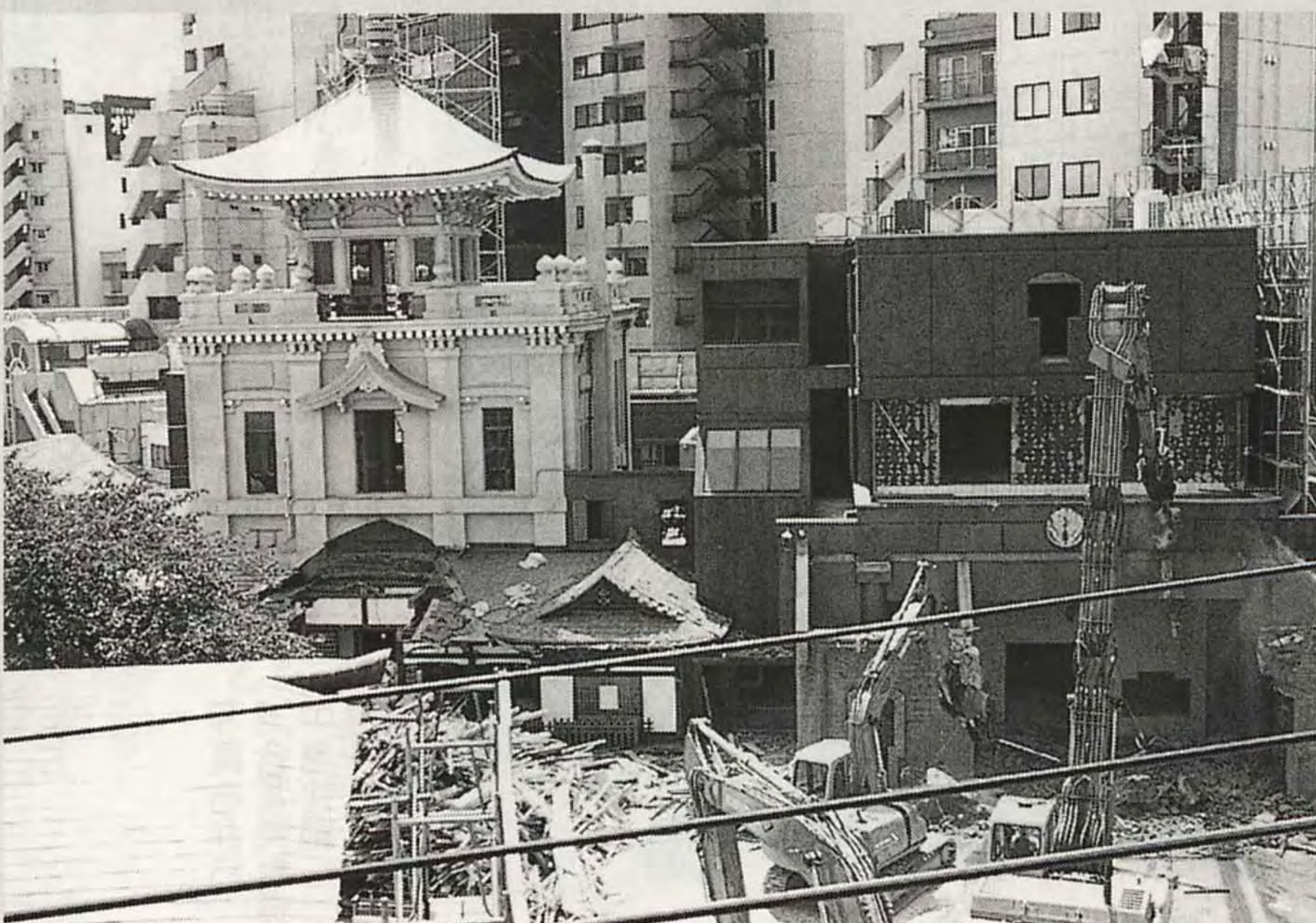
六月中旬より、境内にある全ての建物の解体作業が始まりました。（七月二日撮影）
