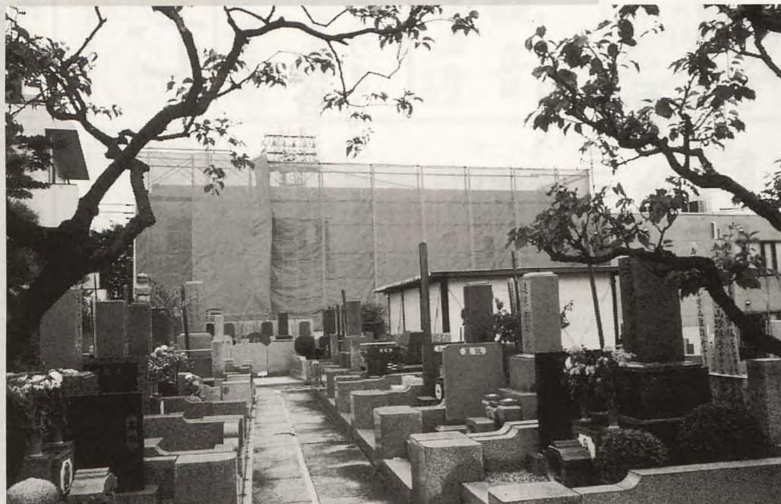
墓地管理棟（工事中）。
