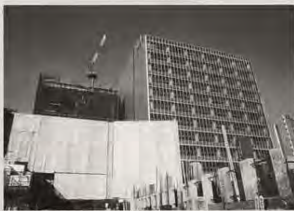
新本堂建設地(一月三十日墓地より撮影) 左手手前は寺院棟、奥は住居棟。右手には業務棟が建つ。
