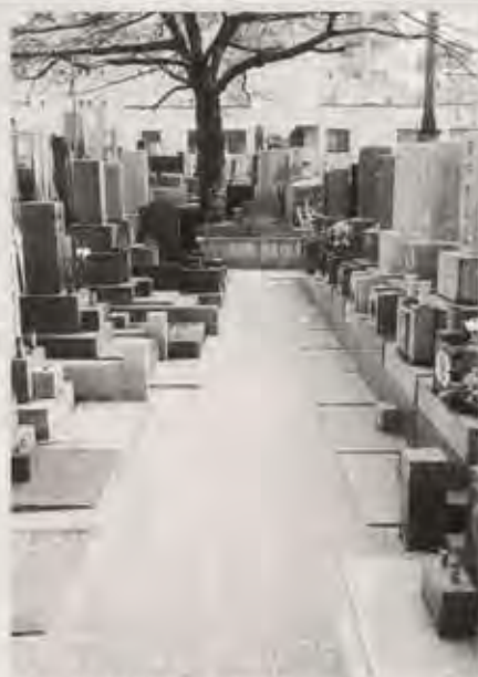
墓地内通路の全面改修工事が進んでおります。雨の日でも足元が滑ることなくお参り頂けます。
